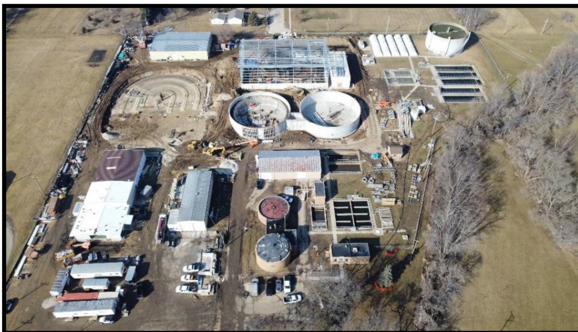
(Proyecto de Ampliación de la Planta de Tratamiento de Aguas Residuales)
